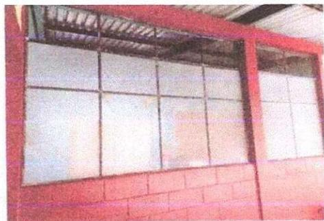
Foto 6: Ventanas: cambio de ventanas fijas con plástico por ventanas móviles con vidrio.
